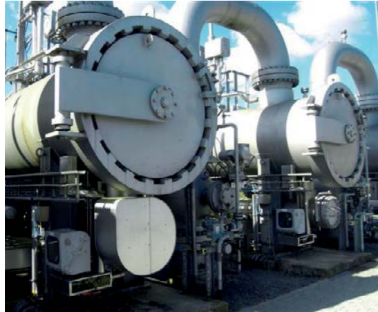
Polvo negro - Sistema de filtrado de una sola etapa
